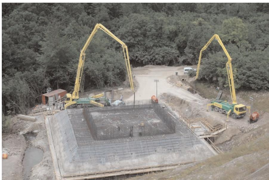
Figura 8. Hormigonado de encepado de pila 2.
