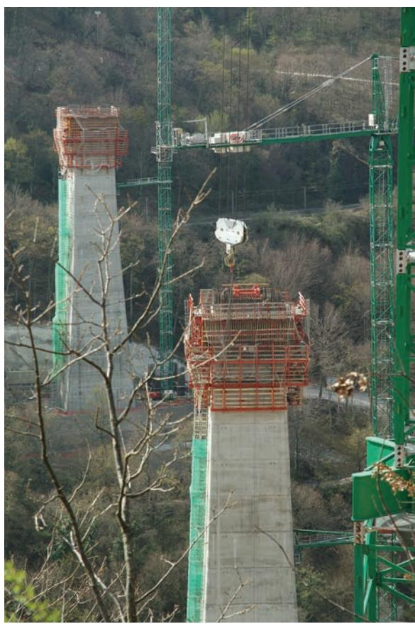
Figura 24. Ejecución de alzados de pilas 2 y 3.
