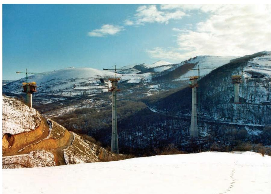
Figura 26. Alzado longitudinal de pilas con dovelas "0" terminadas.
