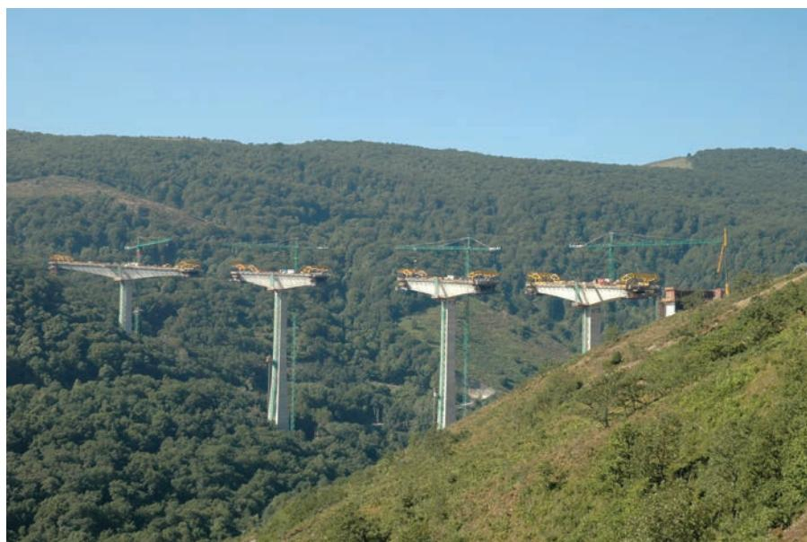
Figura 29. Vista general de las "Ts" de las cuatro pilas.
