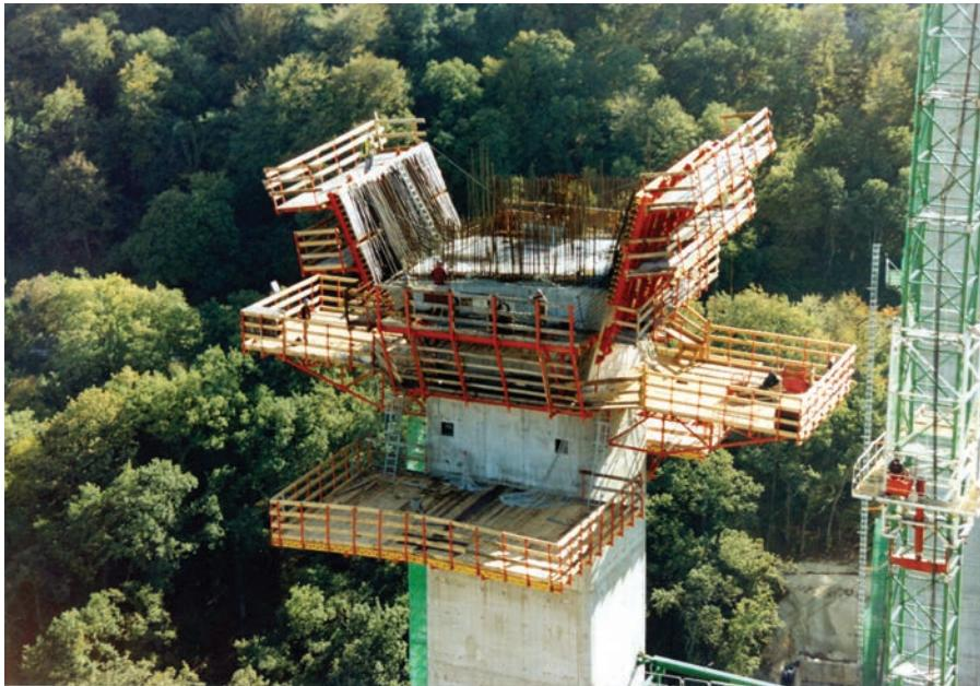
Figura 25. Ejecución de la dovela "0".
