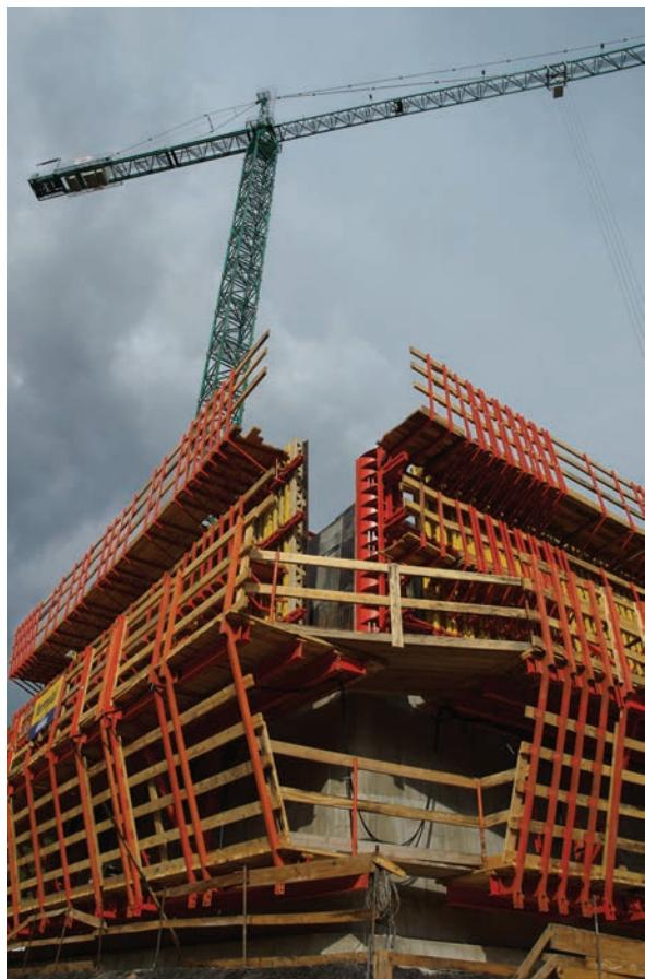
Figura 23. Detalle de autotresa.
