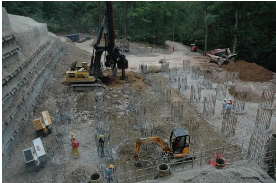
Figura 7. Descabezado de pilotes en pila 3.
