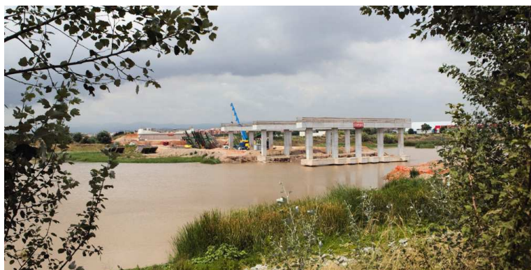
Figura 13. Vista de fase constructiva.
